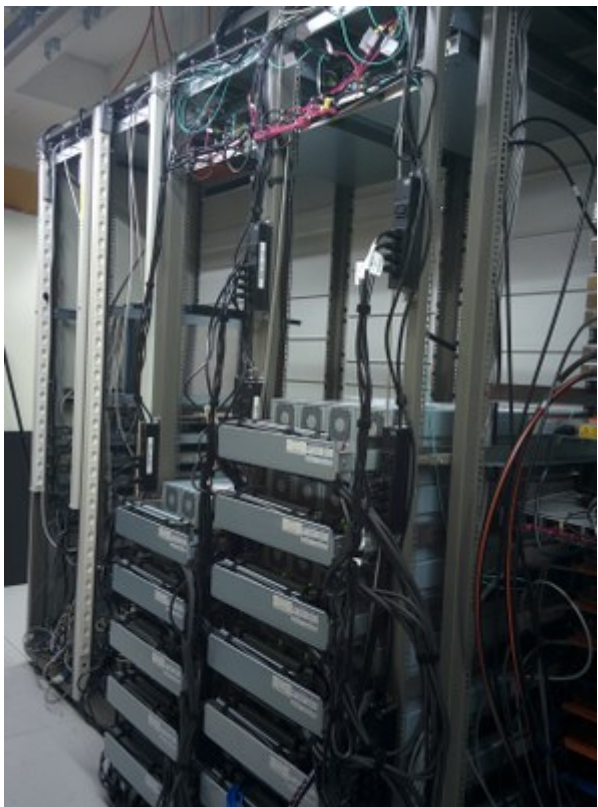
Installation terminée, vue arrière
