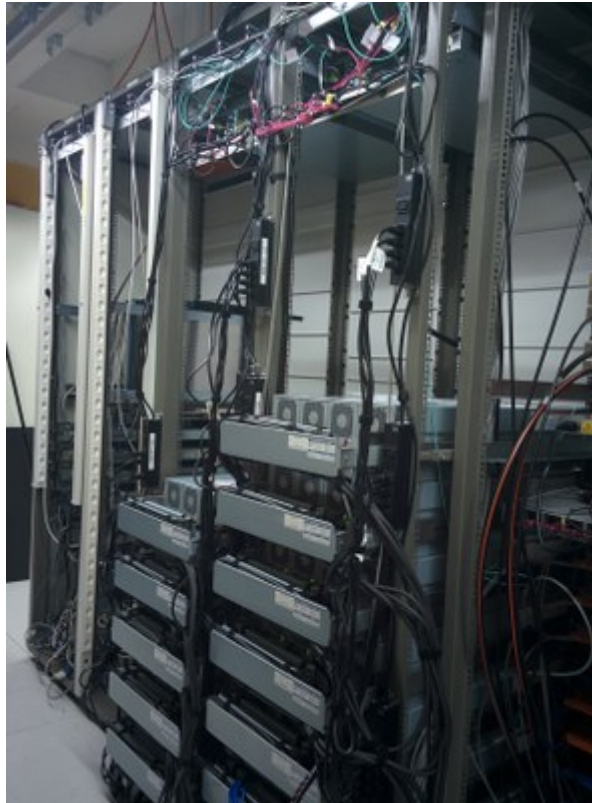
Installation terminée, vue arrière
